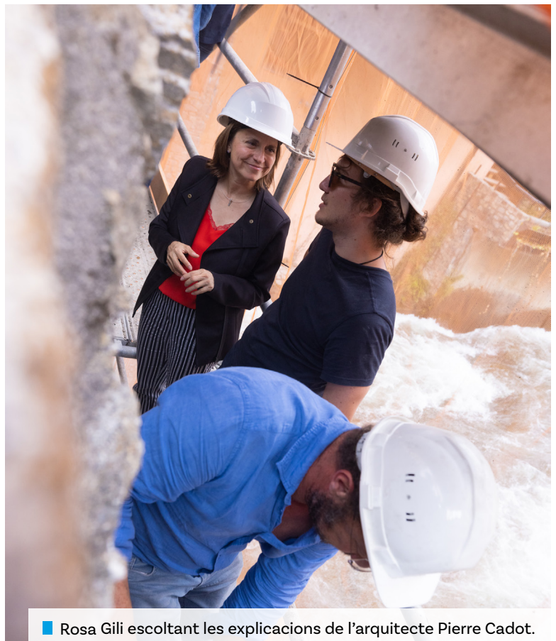
■ La rehabilitació del pont d'Engordany va arrencar al juny.
