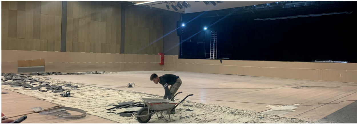
Les obres de manteniment a la sala del Prat del Roure.
